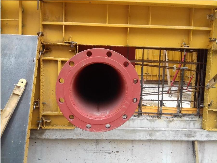
La placa de amure se aprecia dentro del encofrado, pintada con el característico color de la pintura anti-óxido, en un tanque de hormigón armado de 1.500.000 de litros.
