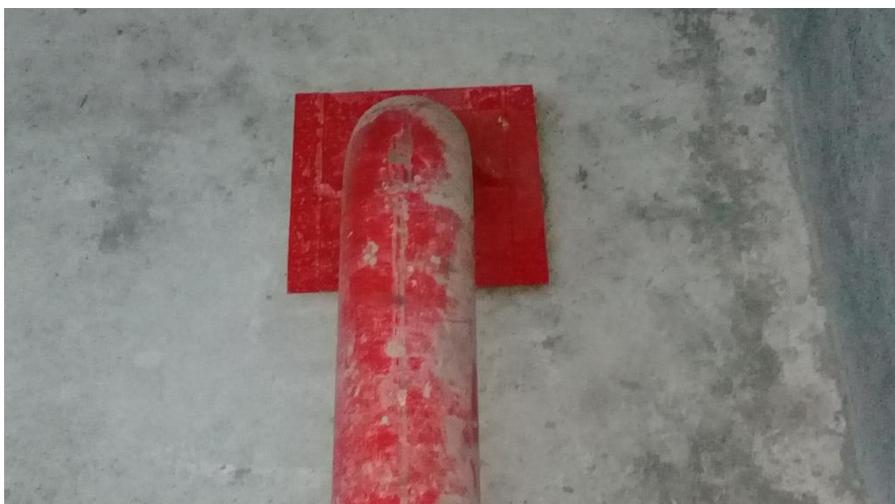
Placa antivórtice en tanque de hormigón armado de 800.000 litros
