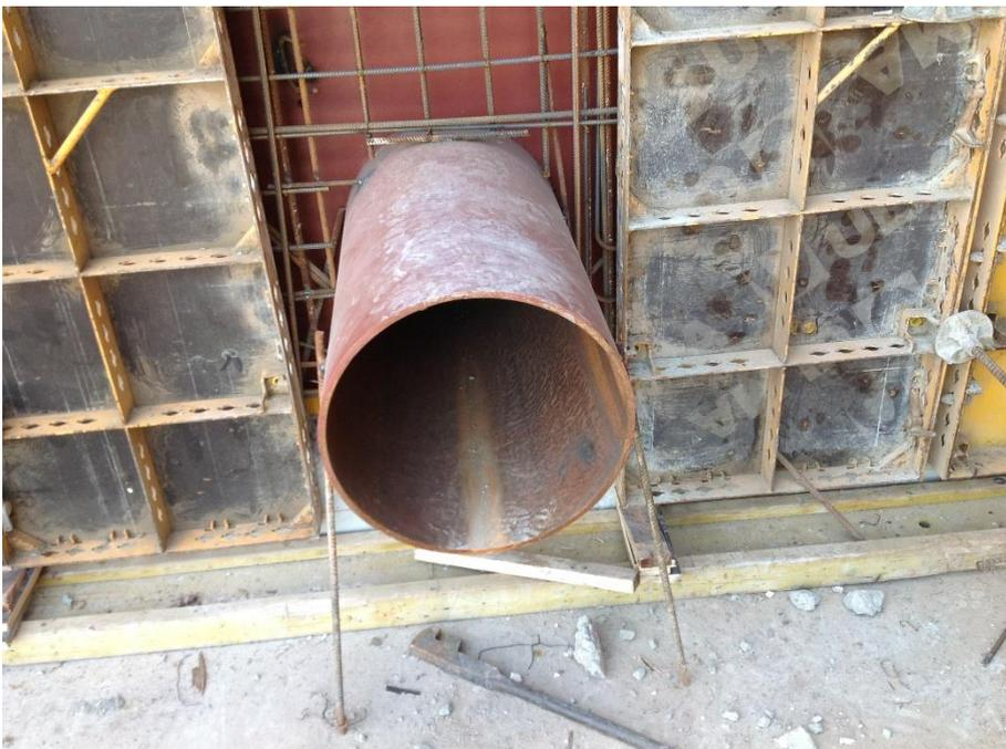
La placa de amure se aprecia dentro del encofrado, pintada con el característico color de la pintura anti-óxido, en un tanque de hormigón armado de 2.000.000 de litros.
