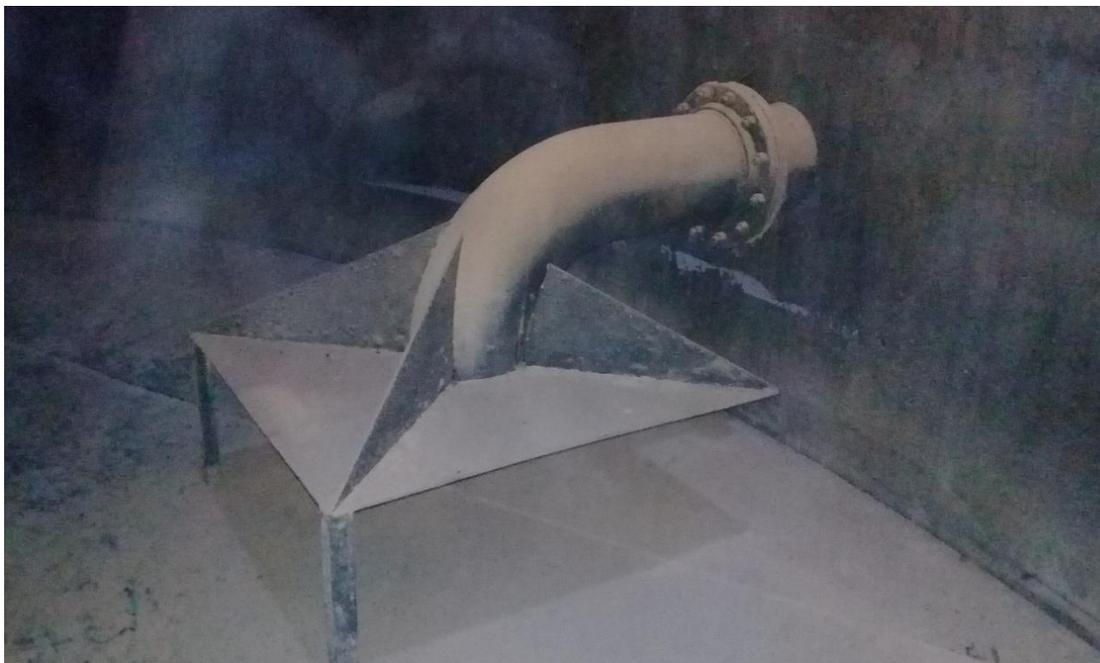
Placa antivórtice en tanque de acero de 2.500.000 litros
