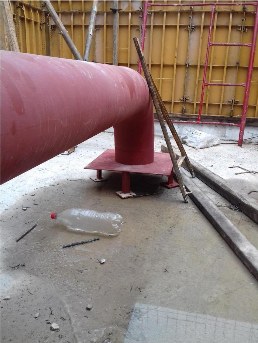
Placa antivórtice en pleno proceso constructivo. Tanque de 1.000.000 de litros
